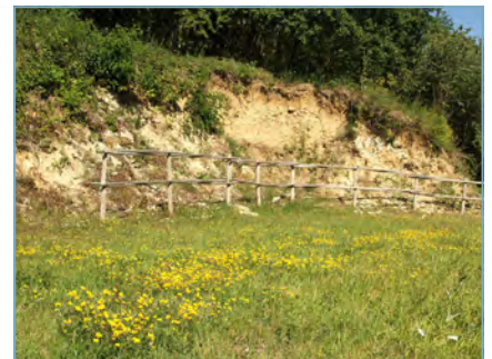
Foto 3: zeer geslaagd herstel van een steilwand in Sint-Truiden (Engelmanshoven)
